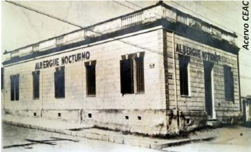
Albergue Noturno antes da destruição por uma tempestade
