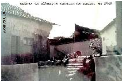
1948 Albergue parcialmente destruído por uma tempestade
