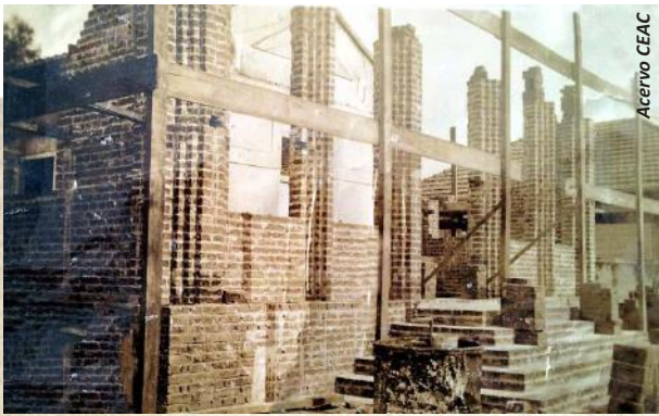
Reforma em andamento
